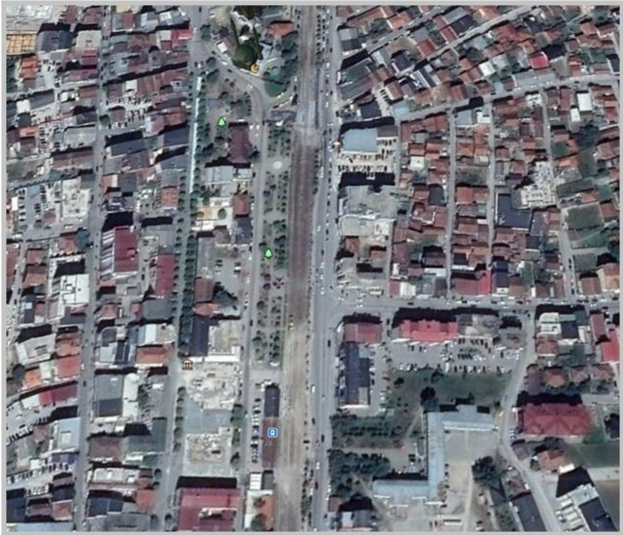
Figura 51. Gjendja aktuale e aksit rrugorë të shqyrtuar, rruga "Ahmet kaçiku " dhe "Vëllezërit Gërvalla"
