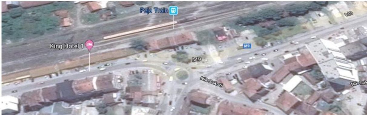
Figura 4.9. Gjendja ekzistuese e rrethrotullimit të dytë te stacioni i trenave, nga Google Maps
