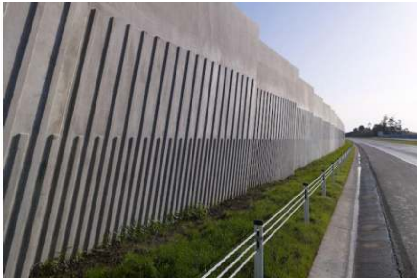
Fig. 4.18 barrierat speciale për ndaljen e zhurmës [1]
