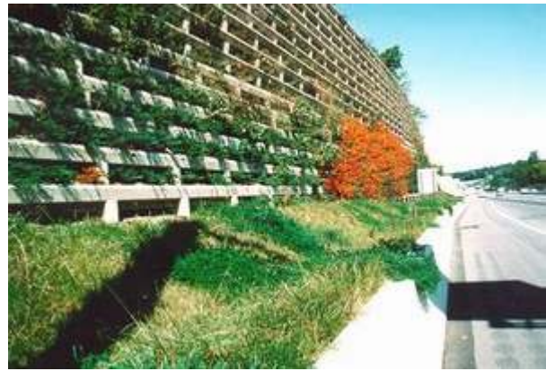
Fig. 4.25 Barriera mikse, (a) me strukturë druri, (b) me strukturë betoni[25]
