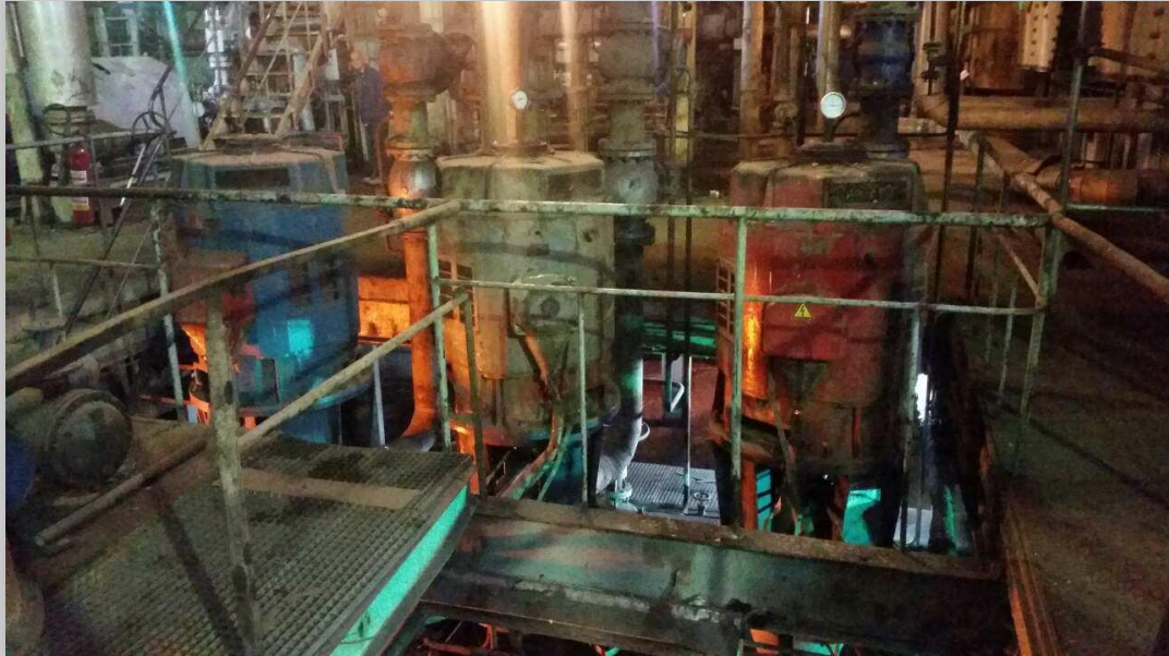
Fig. 3.8. Pamje e pompave kondensuese të TC Kosova A3
