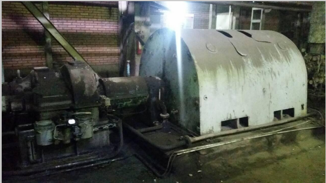
Fig. 3. 10. Pamje e një pompe ushqyese e TC- Kosova A
