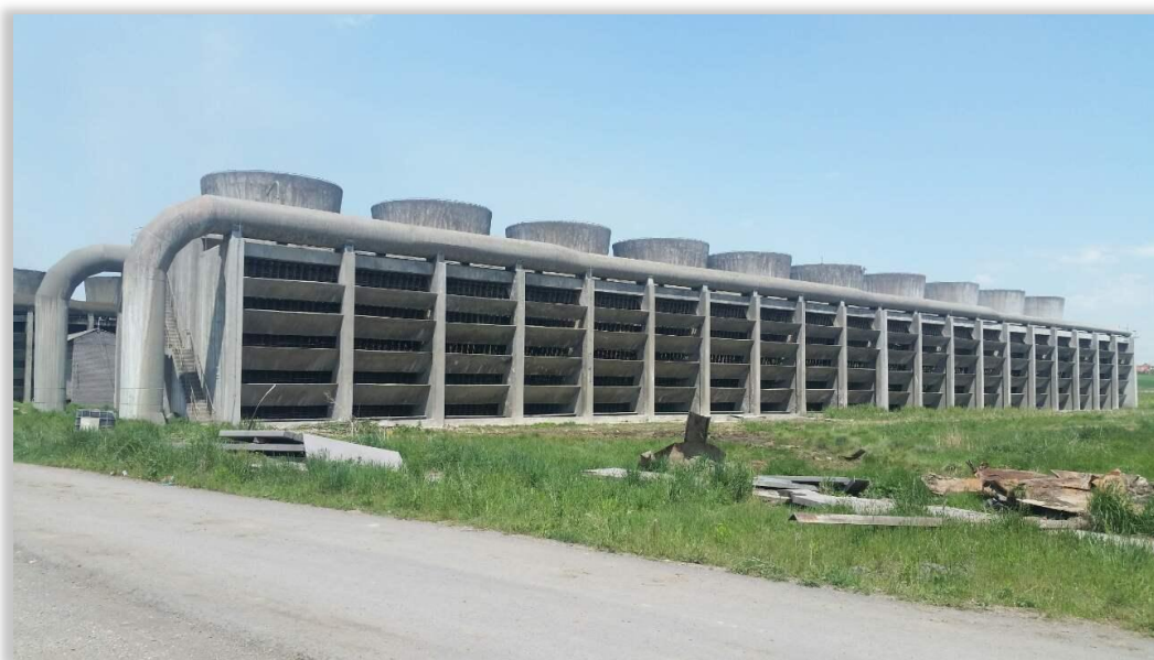
Fig. 3.8. Kulla ftohëse e TC-Kosova A, për ftohje të kondensatit me ajër atmosferik me rrymim të detyruar (ventilator)
