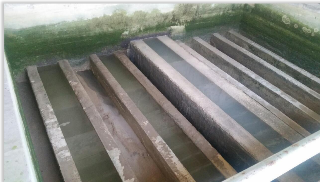
Fig. 3. 13. Filtri gravitacional me shtresa me rërë
