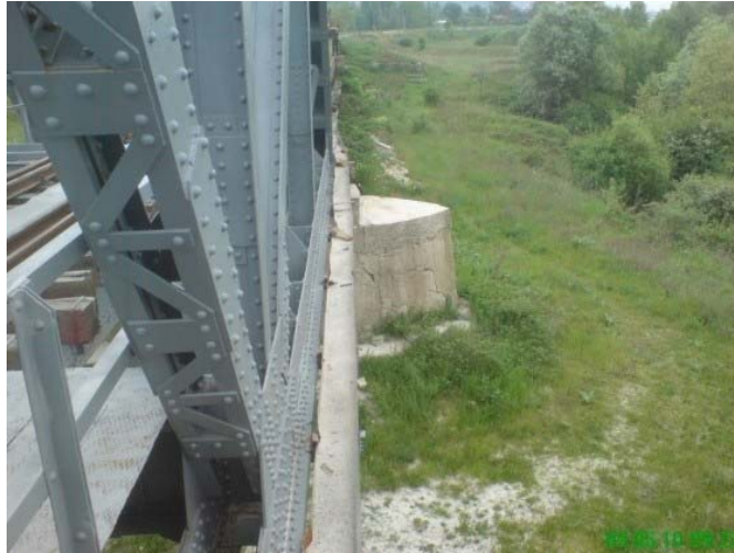
Figura 16 Plasaritja e skelës (shtyllës betonit)
