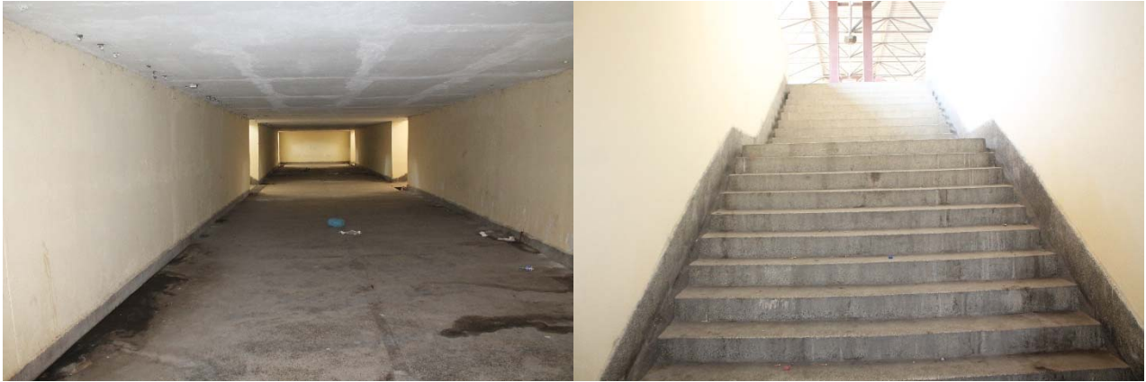
Figura 38 Korridori nëntokësor dhe shkallët e hyrjes dhe daljes nga korridori
