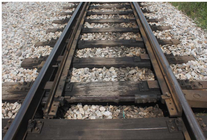
Figura 49 Pragjet e drurit në njërin nga binarët e stacionit hekurudhor Fushë Kosovë.
