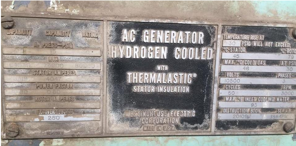
Fig.2.7. Parametrat për gjeneratorin elektrik nga Westinghouse.
