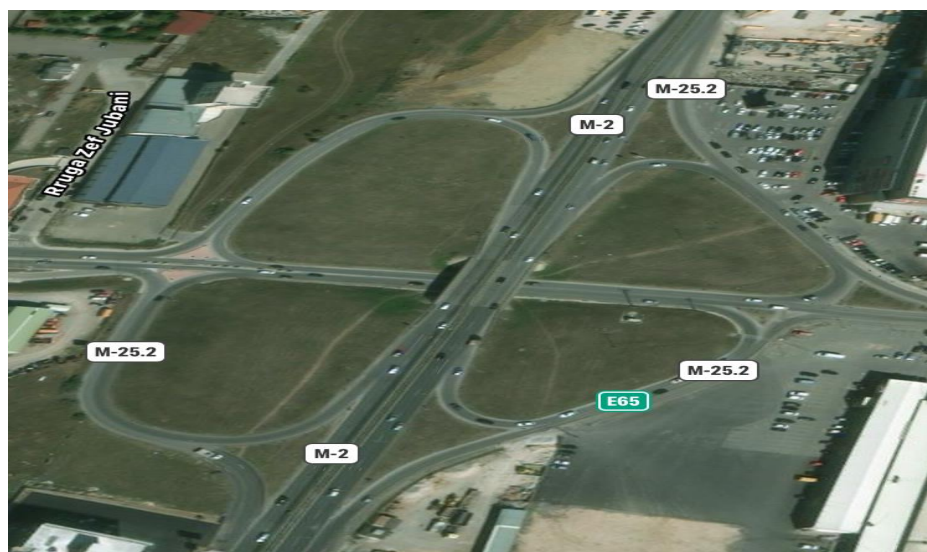
Fig.7.1.2. Pamja ekzistuese e udhëkryqit në disnivel
