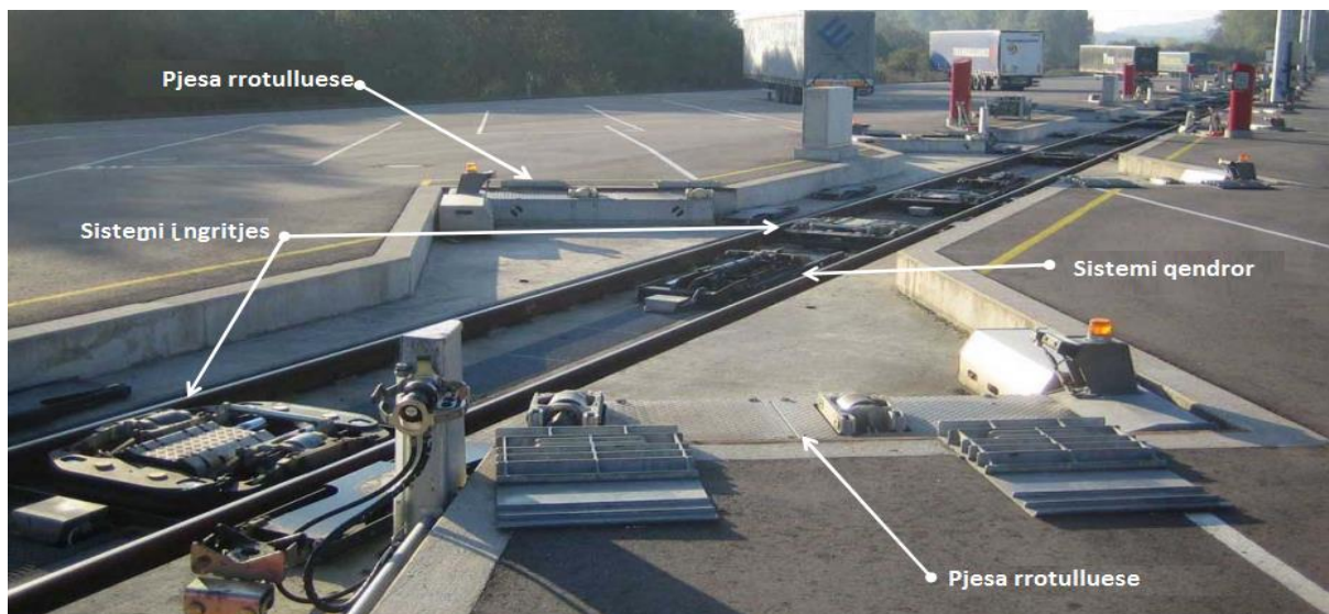
Figura .3.30. Komponentët e terminalit modalohr.
