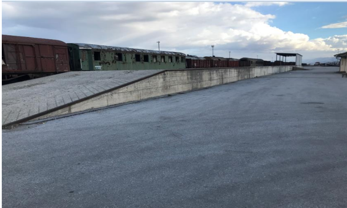
Figura. 8.8. Rampa ngarkuese në terminali e mallrave në Miradi.
