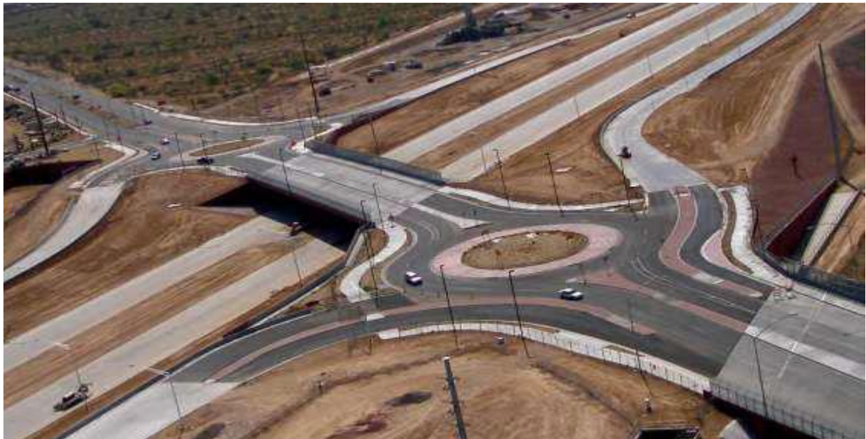
Fig 2.6.3.0 është paraqitur një udhëkryq Diamant me rreth rrotullime në secilin kryqëzim të lidhura me rampa.
