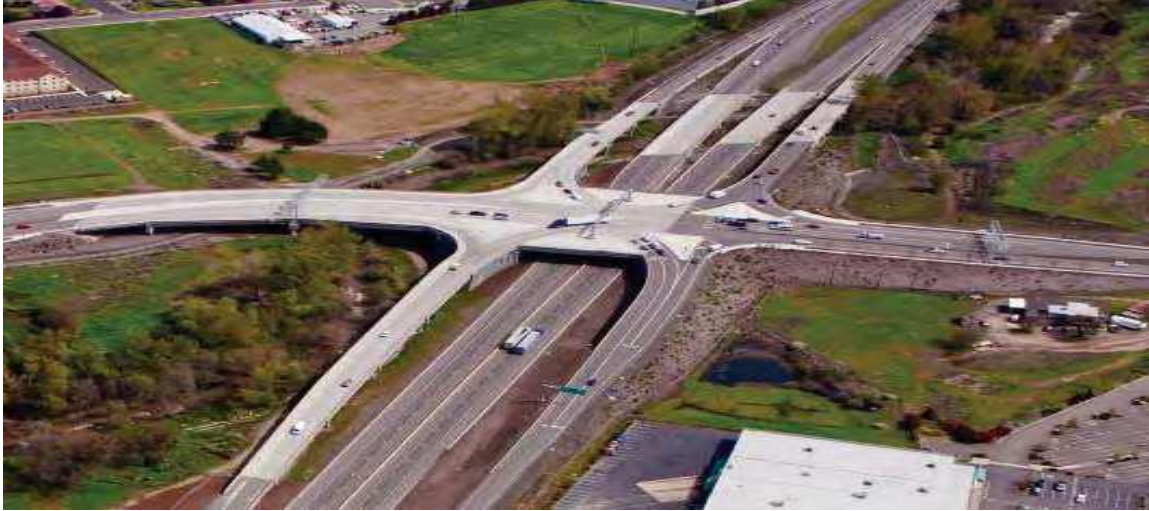
Fig. 2.6.4.1 Paraqet udhëkryqit në disnivel diamant me një pikë me rrugë kryesore e cila rasti par paraqet ku rruga kryesore është nën kalim
