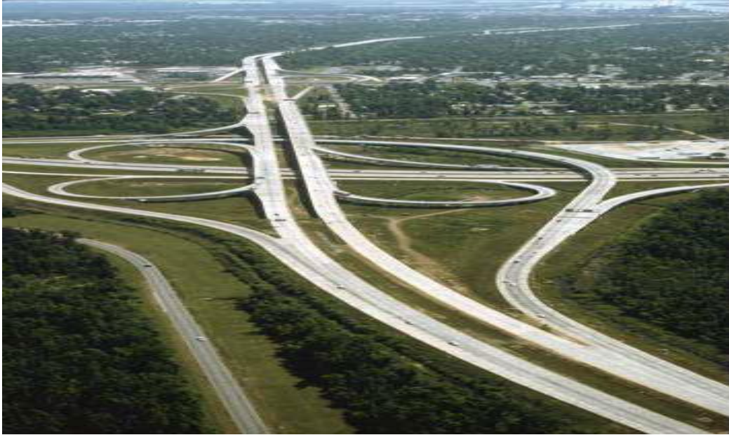
Fig 2.7.2.3. Udhëkryqi në disnivele formës tërfojë me rampa harkore në disnivele me lidhje gjysme direkte me dy drejtimin kryesor .(Karolina Jugore-USA.)
