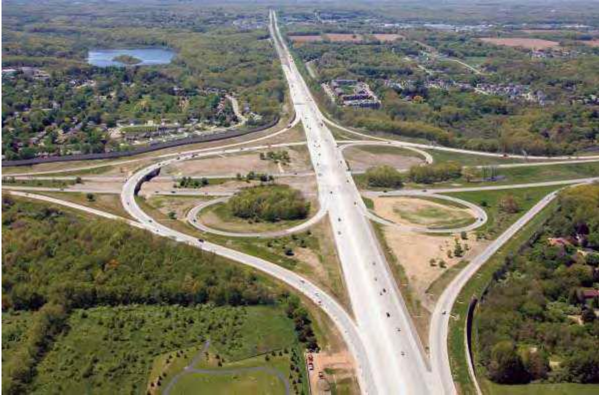
Fig 2.7.2.2 udhëkryqi në disnivel katër krahësh i formës tërfojë me rampa harkore si lidhje gjysme direkte me drejtimin kryesor dhe atë dytësor. (Miqigen-USA.)
