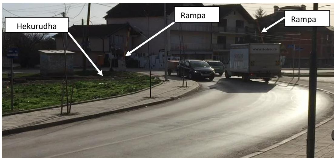
Fig.4.1. Gjendja ekzistuese e udhëkryqit mbi të cilin kalon hekurudha
