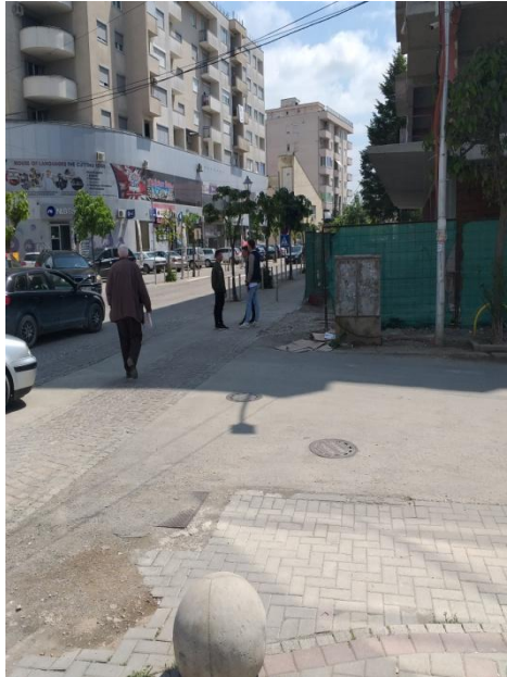
Figura 5.14: Mungesa e sinjalizimit vertikal si dhe vendkalimit të këmbësorëve
