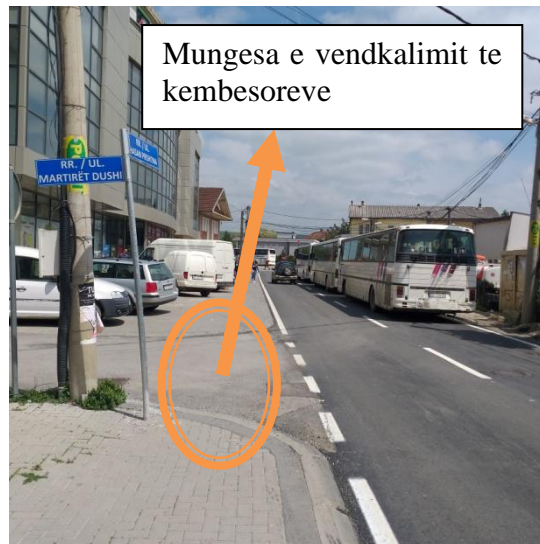
Figura 4.8: Gjendja e sinjalizimit horizontal në rrugën "Hasan Prishtina"
