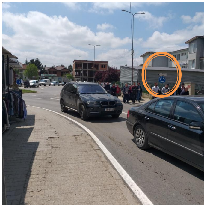
Figura 7.39: Mungesa e shënjes për definimin e përparësisë së kalimit
