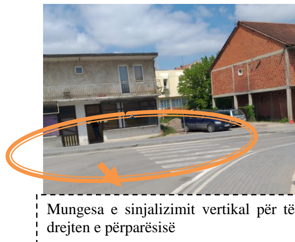
Figura 4.5: Mungesa e sinjalizimit vertikal tek vendkalimet e shënuara për këmbësorë
