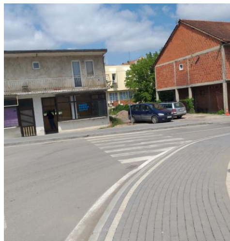
Figura 5.5: Mungesa e shenjës “Vendkalim i shënuar për këmbësorë”
