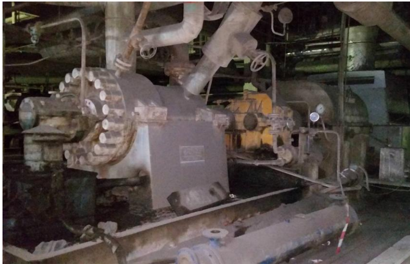
Fig.2.14. Pompa ushqyese e bllokut A2
