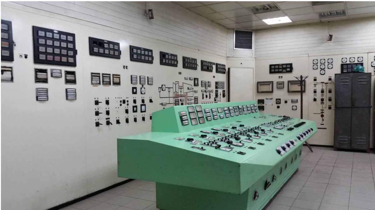
Fig.2.3. Instrumentet matëse dhe manipuluese elektrike të kaldajës dhe turbo-gjeneratorit për bllokun A2.
