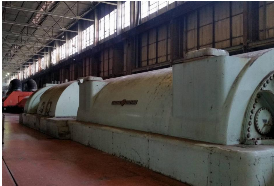
Fig.2.4. Turbina e avullit e blloku A2 e cila përbëhet nga turbina me presion të lartë dhe turbina me presion të ulët.
