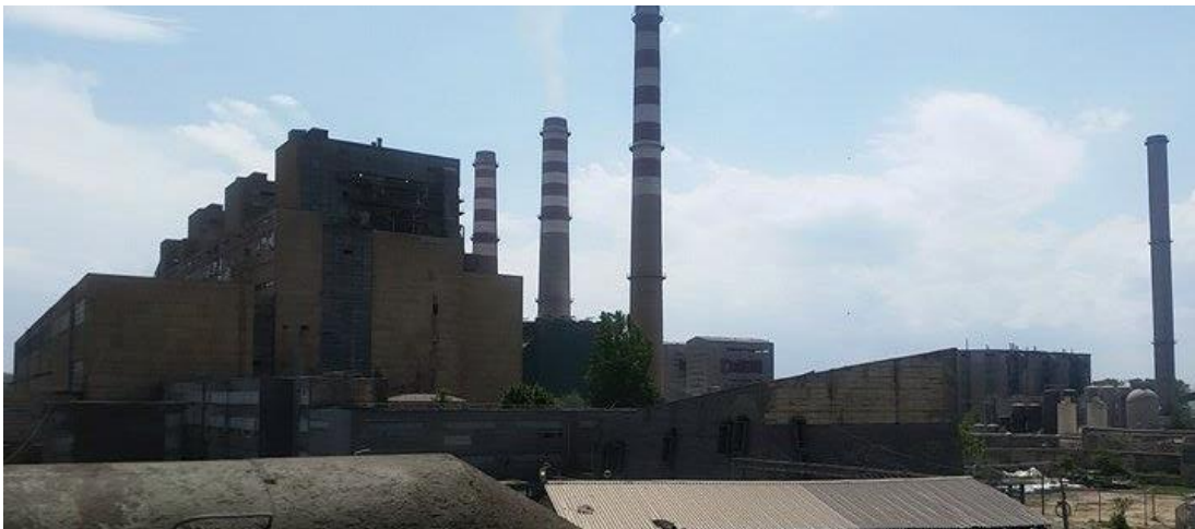
Fig.2.1. Termoelektrocentrali Kosova A
