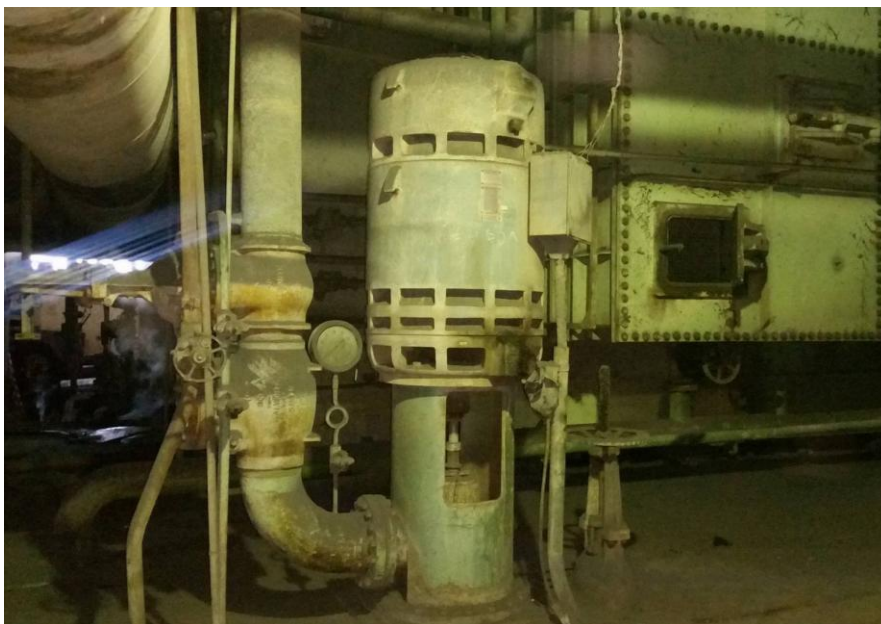
Fig.2.11. Pompa e kondensatit
