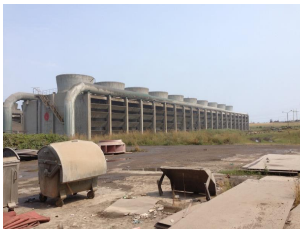
Fig.2.2. Kulla ftohëse e termoelektrocentralit të bllokut A5
