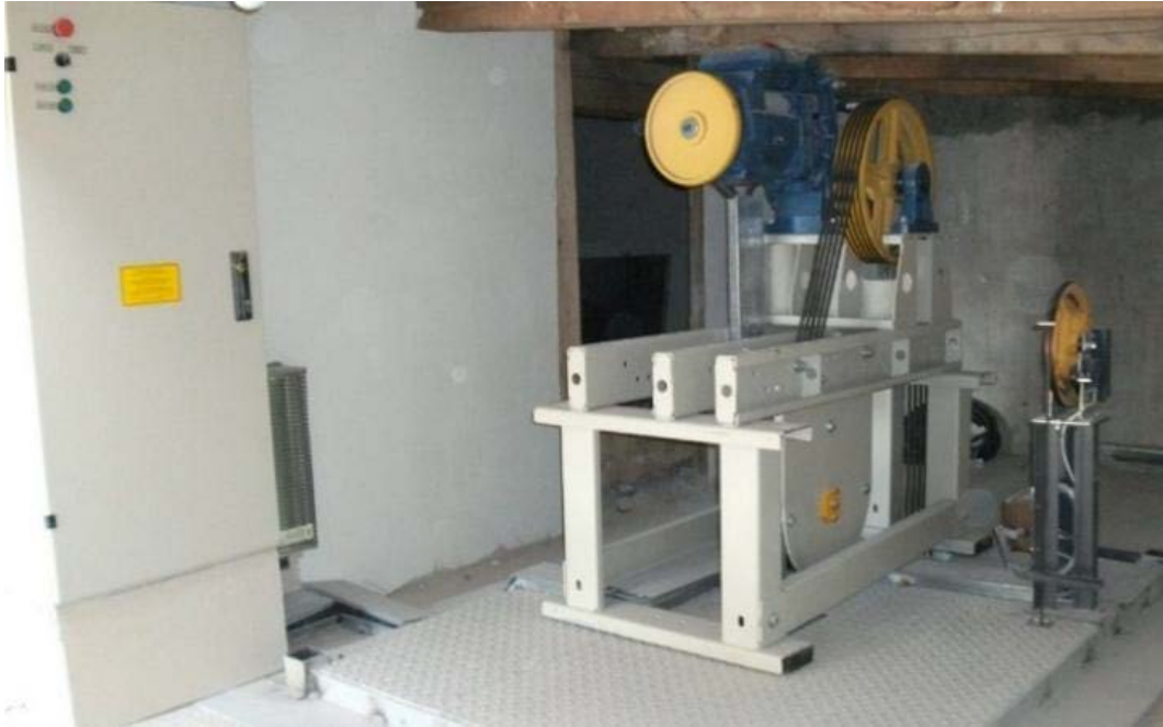
Fig. 3.3.1. Dhoma e makinerisë me mekanizmin e lëvizjes.
