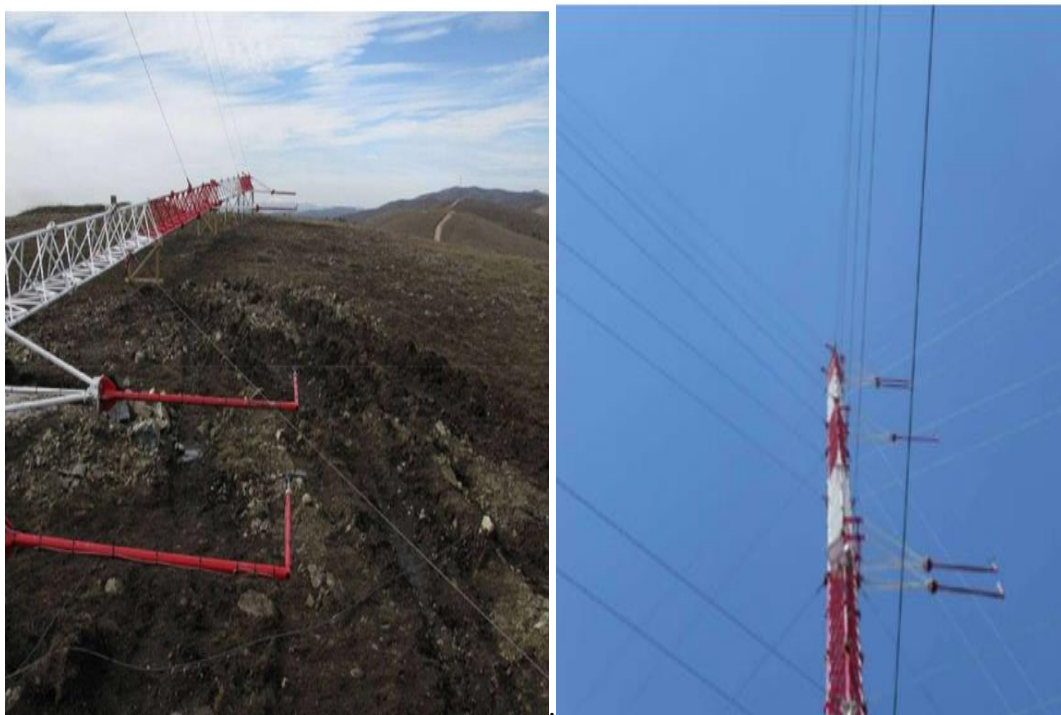
Fig. 7.3. Fotot e pajisjeve matëse në mikrolokacionin e parkut Koznica gjatë dhe pas instalimit
