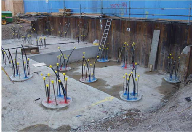
Fig. 3.19. Instalimi i këmbyesit vertikal.
