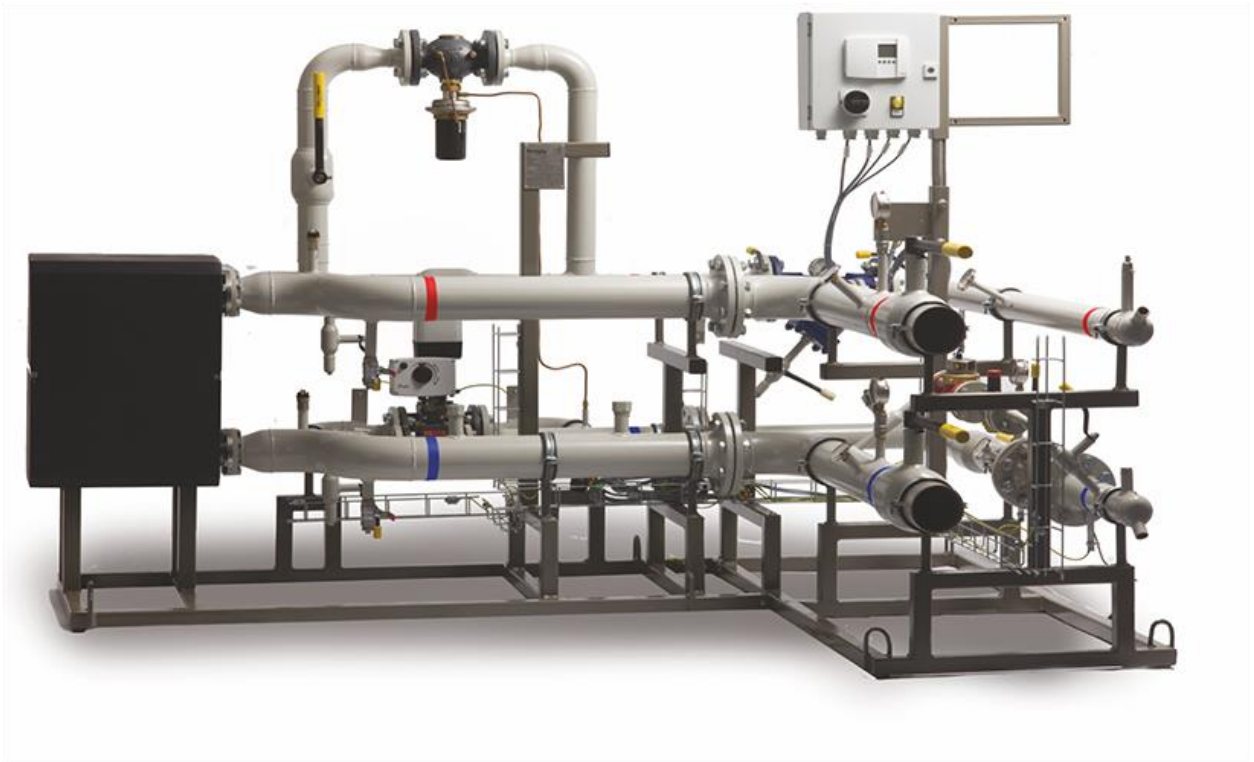
fig.7.5. Pamja e nënstationit termik në lagjën Albanica
