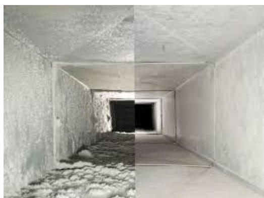
Fig. 2.15. Kanal para dhe pas pastrimit
