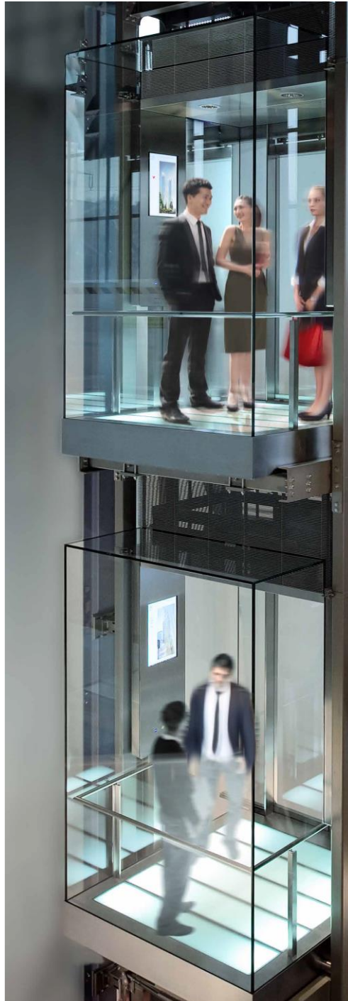
Fig 2.7 Ashensorë dy etazhorë i vendosur në ndërtesë [10].
