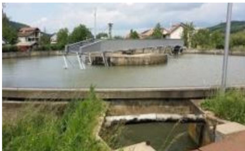
Fig. 3. Reaktori për përgatitjen fillestare e ujit.
