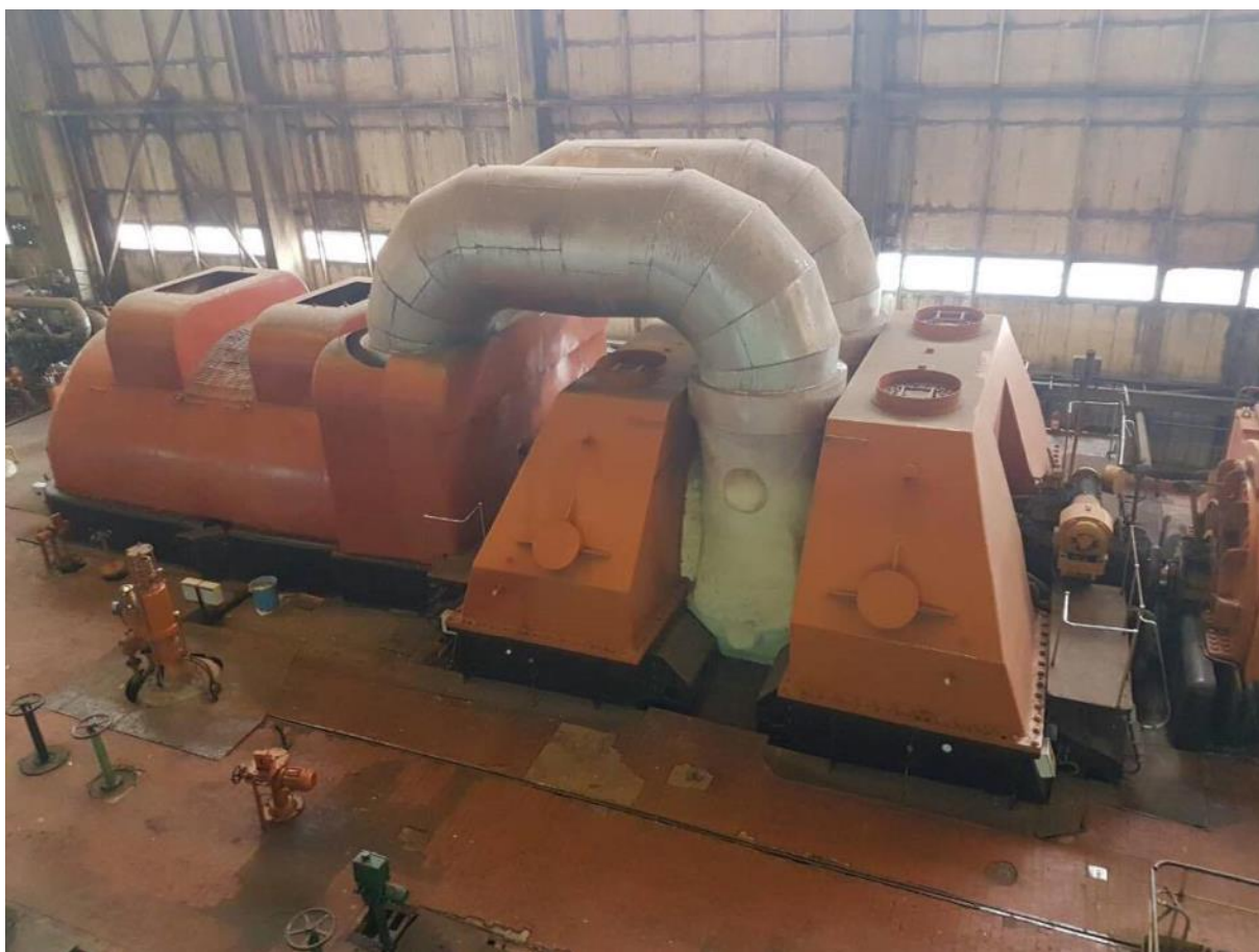
Fig. 2.8. Turbina e presionit të lartë TPL, Turbina e presionit të mesëm TPM dhe Turbina e presionit të ulët TPU.
