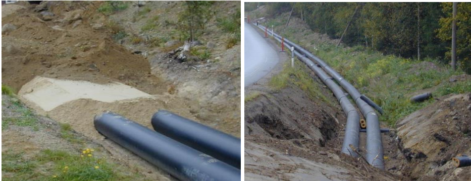
Figura 3.13 Përdorimi i tubave dhe izolimeve të ndryshme
