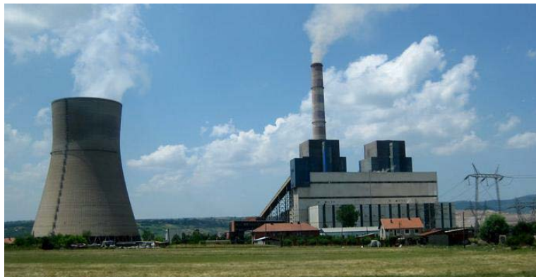
Fig. 1.8. Termocentrali “Kosova B
