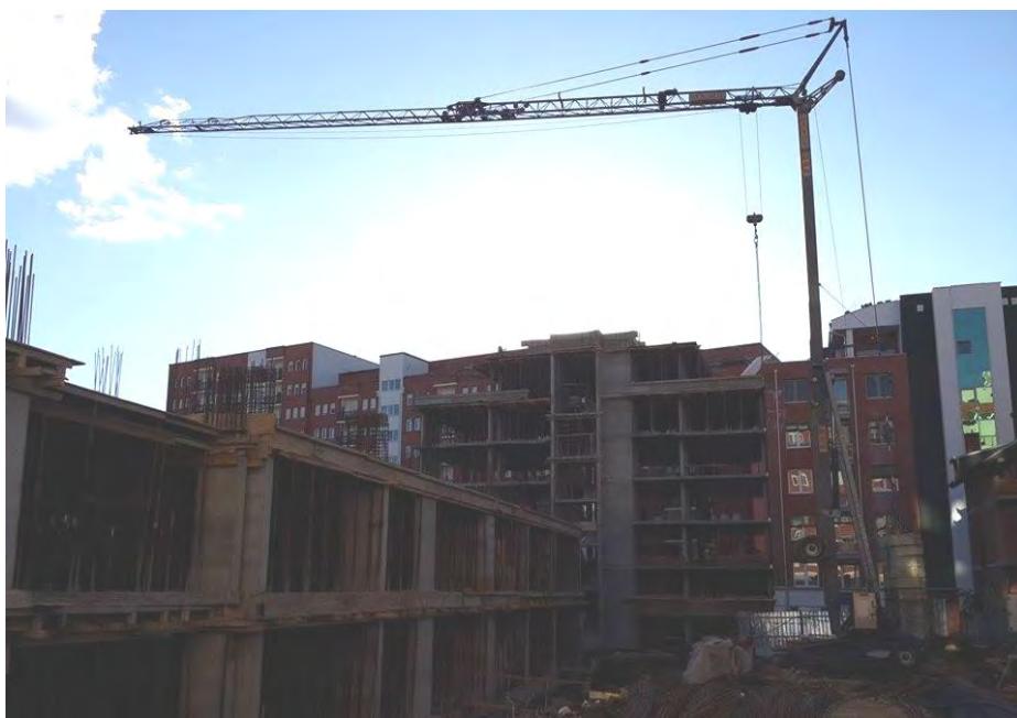
Fig.2.1. Foto e vinçit vetmontues të ndërtimit të tipit H.S. 23.09 .
