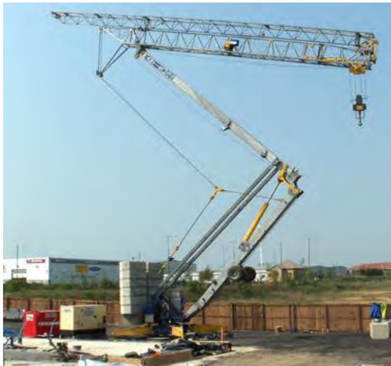
Fig.1.2. Shembuj të montimit të vinçit vetmontues të ndërtimit [18] [19].
