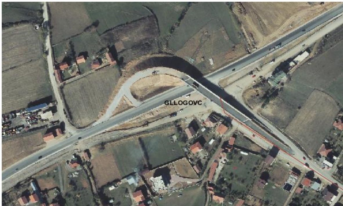
Figura 2.20. Udhekryqi në disnivel në kryqëzimin e rrugëve Prishtinë – Pejë dhe rrugës për Malishevë
