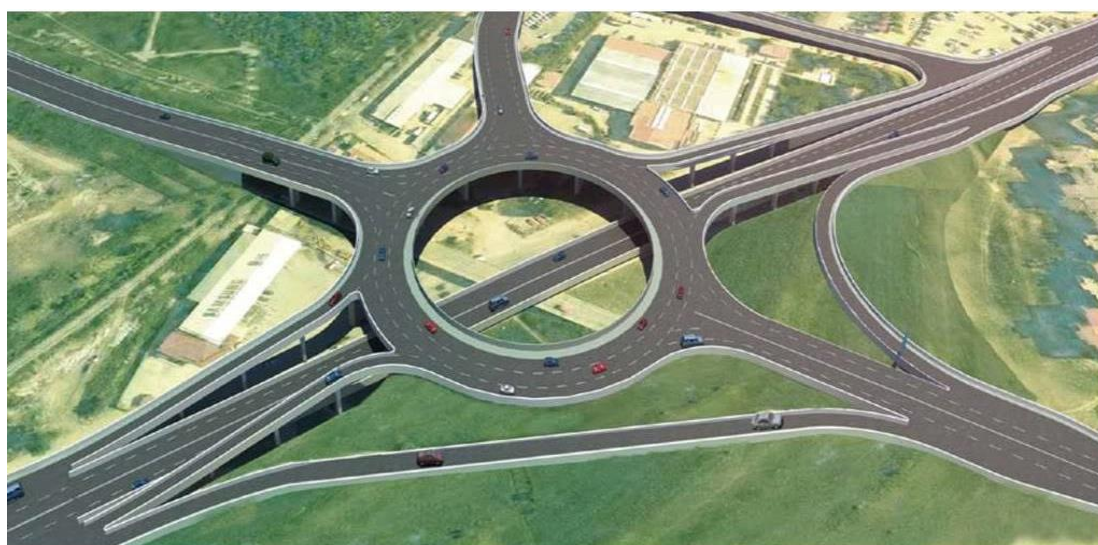
Figura 2.16. Udhëkryqi në disnivel në 3D i formës rrethore në kryqezimin e rrugëve magjistrale M9 dhe M2
