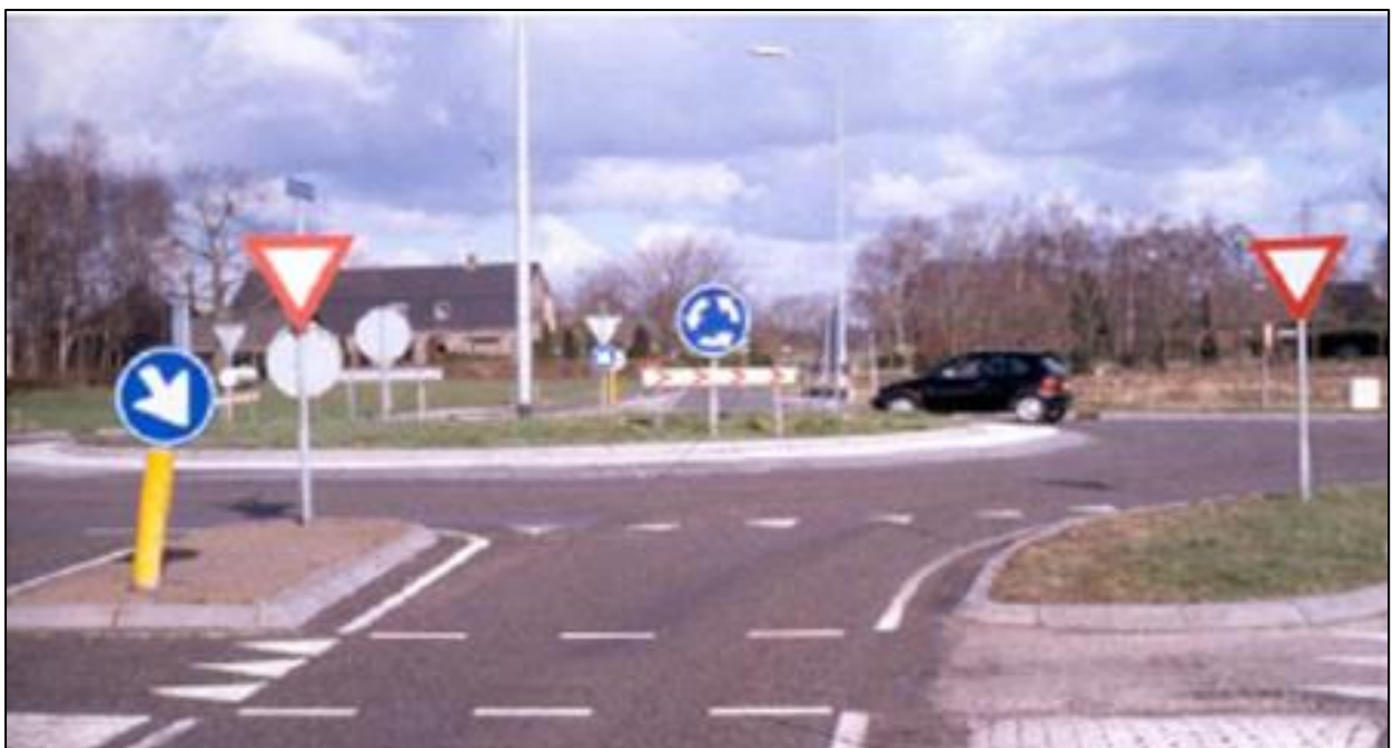
Figura 3.18. Vendosja e sinjalizimit vertikal në rrethrotullime urbane.
