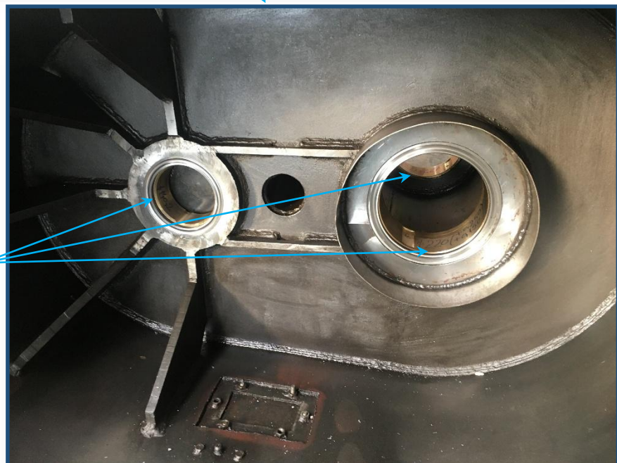
Fig. 2.14. Kushinetat rrëshqitëse radiale të montuara në shtëpizën e reduktorit të rrotës punuese të ekskavatorit, që përdoret në mihjen sipërfaqësore të thëngjillit në Korporatën Energjetike të Kosovës- KEK [6].
