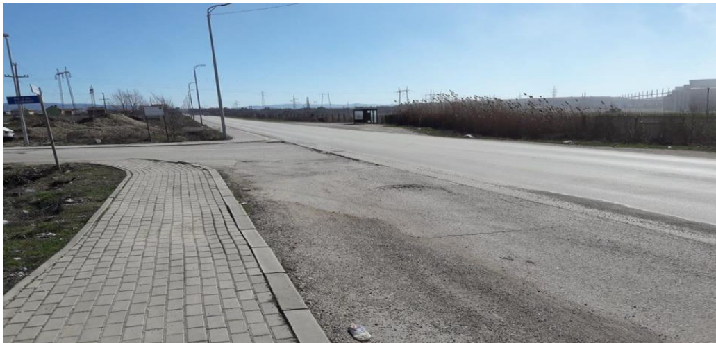
Fig.4.14. Gjendja egzistuese e rrugës përballë termocentralit “Kosova A”
