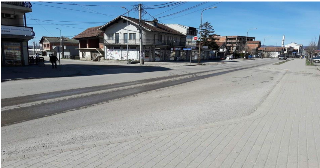
Fig.1.4. Udhëkryqi numër 2 . (Ortofoto dhe foto e terrenit ),Udhëkryqi që gjendet afër shtëpisë së shendetit është i formës (T) ku kryqëzohet me rrugët “ Hasan Prishtina“, dhe “Vëllzërit Frashëri“.
