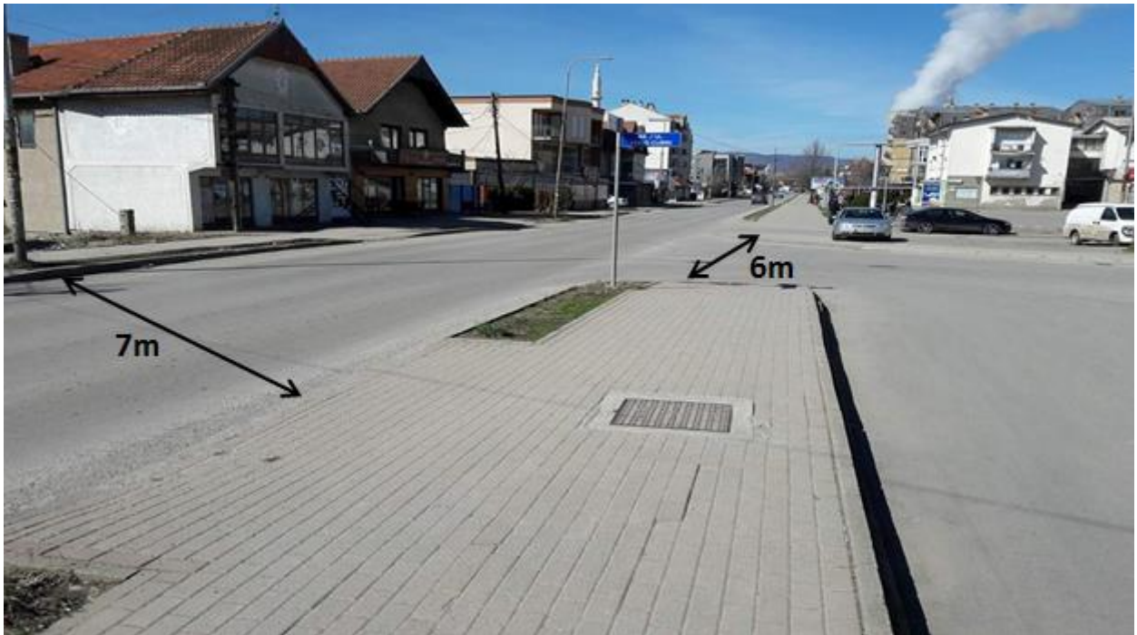
Fig.2.12. Dimnzionet e udhëkryqit të formës “T” në qendër të Obiliqit
