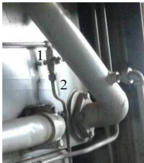
Figura 3.56: 1- rregullatori pneumatik i kompresorit, 2- rubineti për lirim të llumit nga rregullatori
